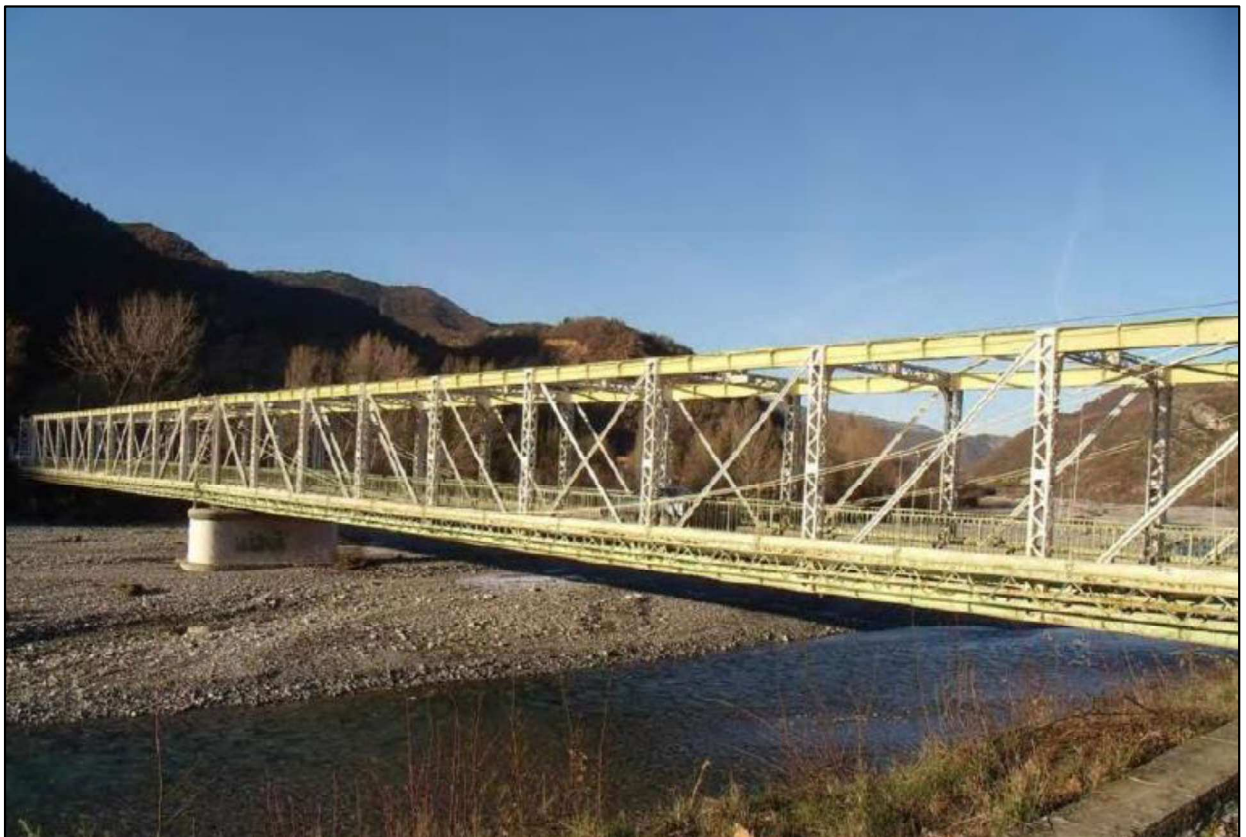
Figure 6 Élévation aval de l'ouvrage existant (SCE, 2019)
